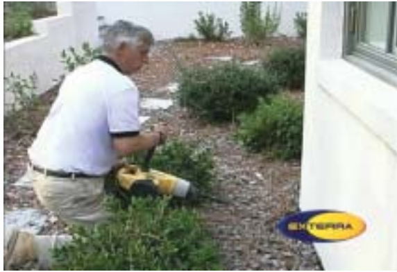
Préparation d'une barrière d'injection
